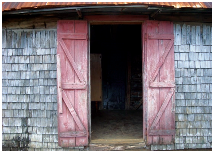
Façade couverte de bardeaux
