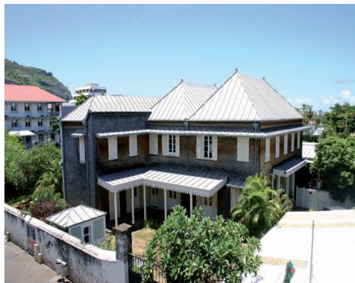
Maison Déramond Barre Façade latérale soufflée de bardeaux - Saint-Denis
