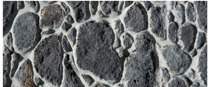
Appareillage - Mur en moëllon
