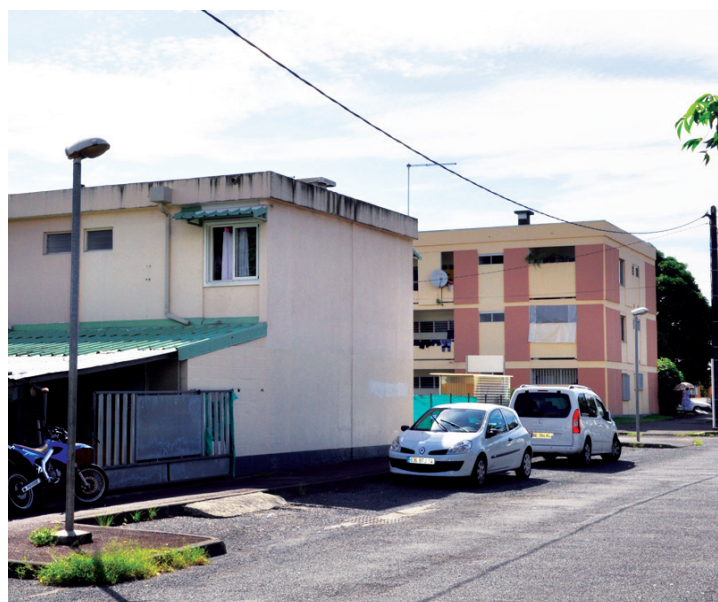
Cité Labourdonnais - Petite maison en bande et barre béton Saint-Benoît
